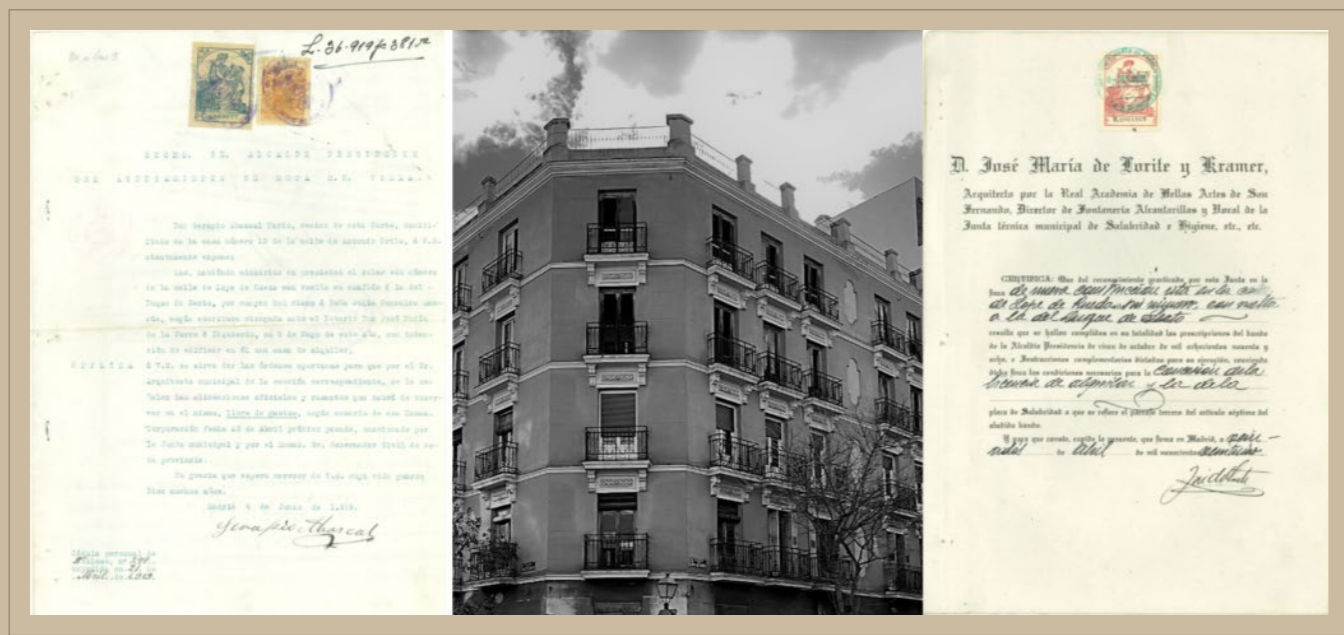
Detalle de la fachada del edificio, donde se han conservado las características originales de los balcones y molduras
